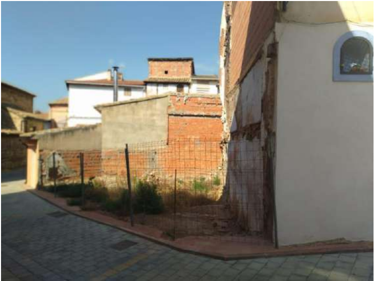
Vista de la parcela en la que se construiría el nuevo multiservicio ubicada junto al horno municipal, cuya pared medianera se observa en la fotografía adjunta.
